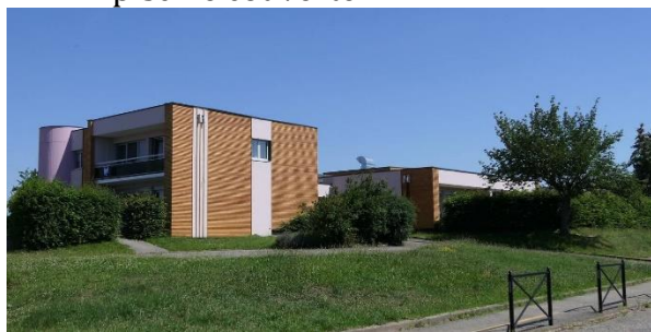
Les bâtiments rénovés pour devenir à énergie positive du groupe scolaire./Ungersheim
